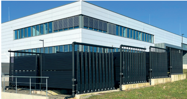
Energiezaun mit 88 Solar-Luftabsorber-Einheiten
