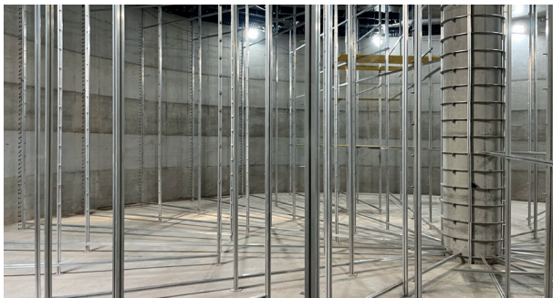
Blick in den Eis-Energiespeicher vor der spiralförmigen Verlegung des Wärmetauschers
