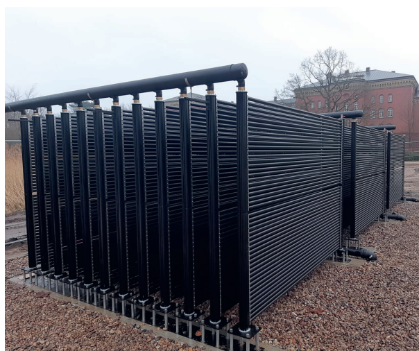
Solar-Luft-Kollektor (Energiezaun) als direkte Energiequelle für die Wärmepumpe oder zur Regeneration des Eis-Energiespeichers
